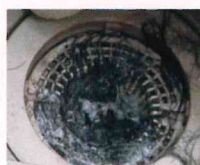
浴室の排水の詰まりや悪臭
